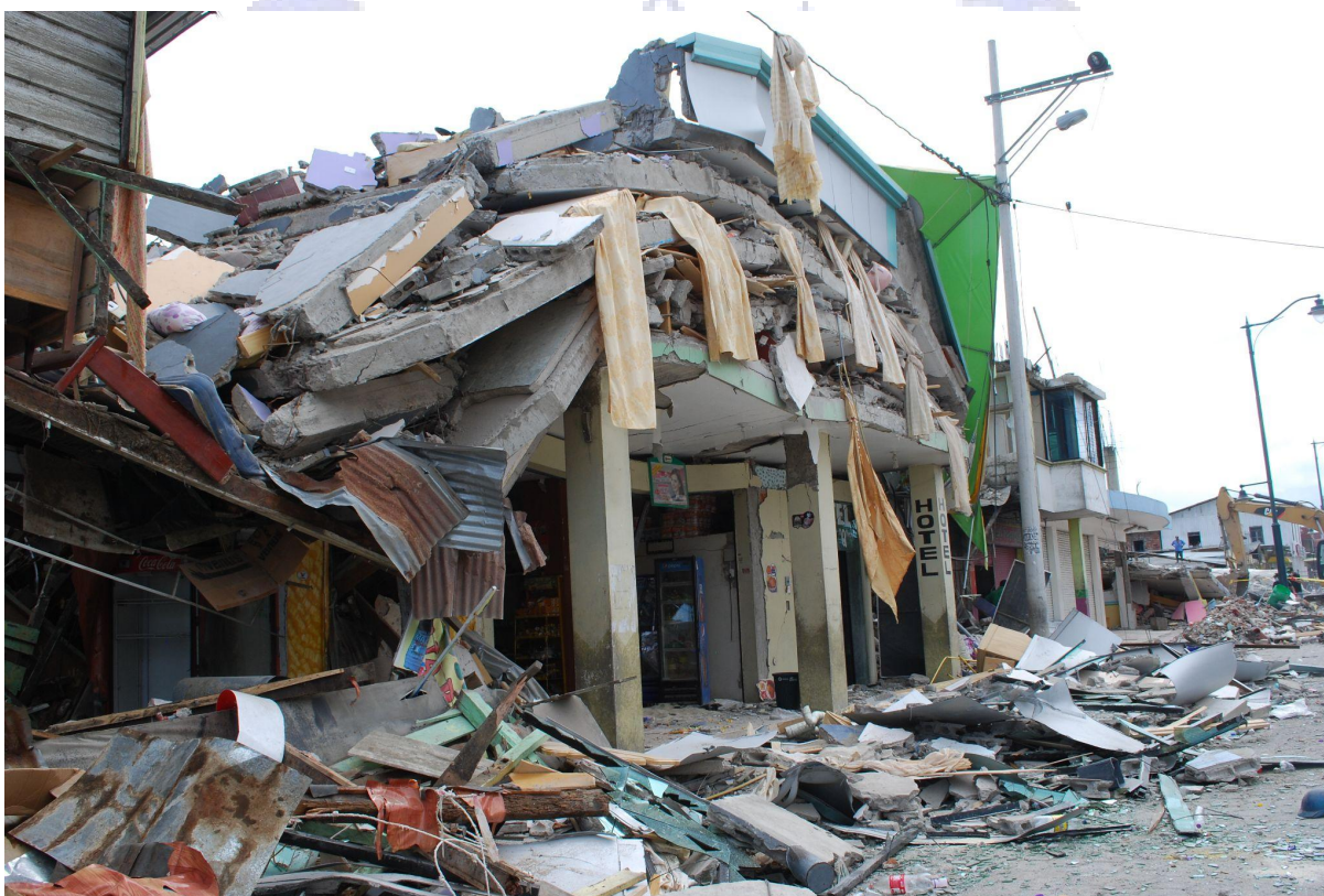
Imagem: Prédios destruídos pelo terremoto de magnitude 7,8 no Equador (Cortesia da Cruz Vermelha Equatoriana)
